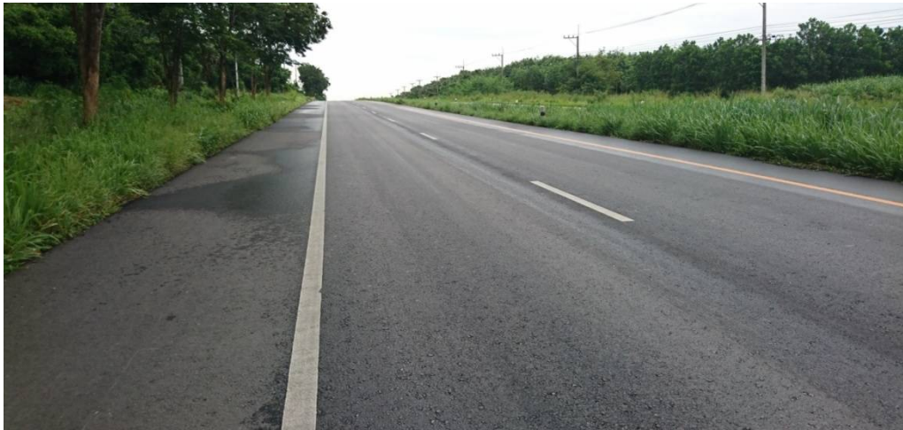
ภาพที่ 8.3 รูปภายหลังจากการบูรณะทางหลวงหมายเลข 344 ตอน อ.บ้านบึง – อ.แกลง กม. 39+ 800 RT
