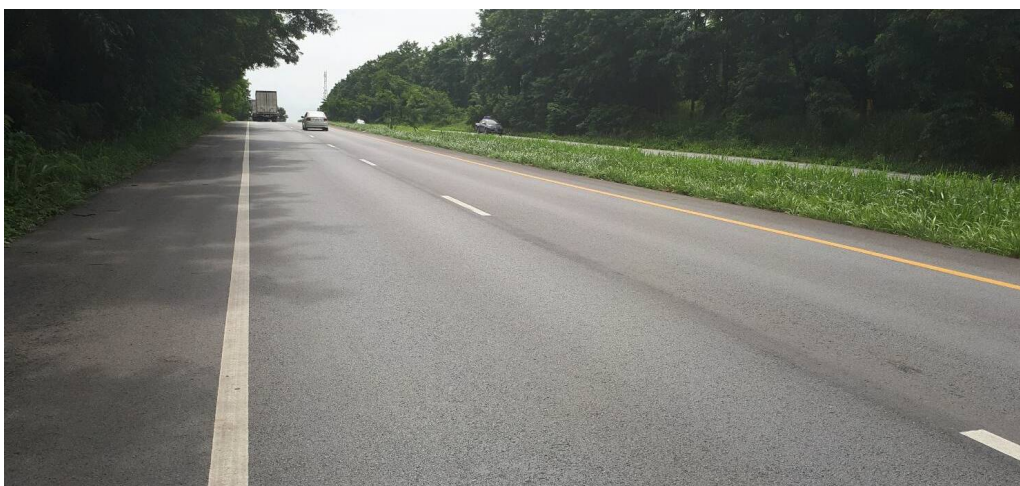
ภาพที่ 8.4 รูปภายหลังจากการบูรณะทางหลวงหมายเลข 344 ตอน อ.บ้านบึง – อ.แกลง กม. 45+ 000 RT ผลการประเมินความแข็งแรงของโครงสร้างชั้นทางตาม AASHTO 1993
