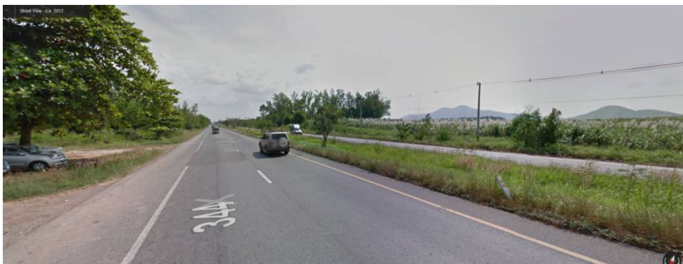
ภาพที่ 6.3 รูปก่อนการบูรณะทางหลวงหมายเลข 344 อ.บ้านบึง – อ.แกลง (ภาพจาก Google Street View)
