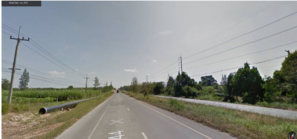
ภาพที่ 6.5 รูปก่อนการบูรณะทางหลวงหมายเลข 344 อ.บ้านบึง – อ.แกลง (ภาพจาก Google Street View)
