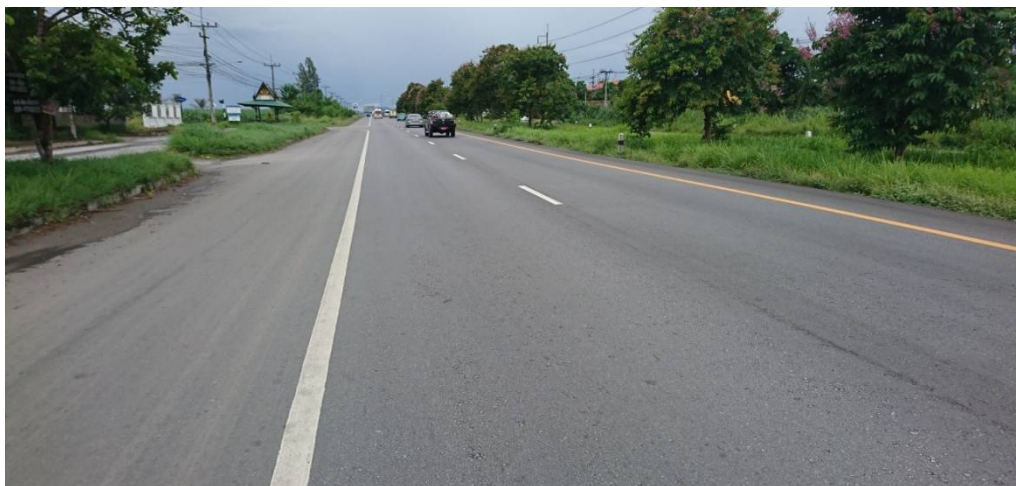
ภาพที่ 8.1 รูปภายหลังจากการบูรณะทางหลวงหมายเลข 344 ตอน อ.บ้านบึง – อ.แกลง กม. 33+ 000 LT
