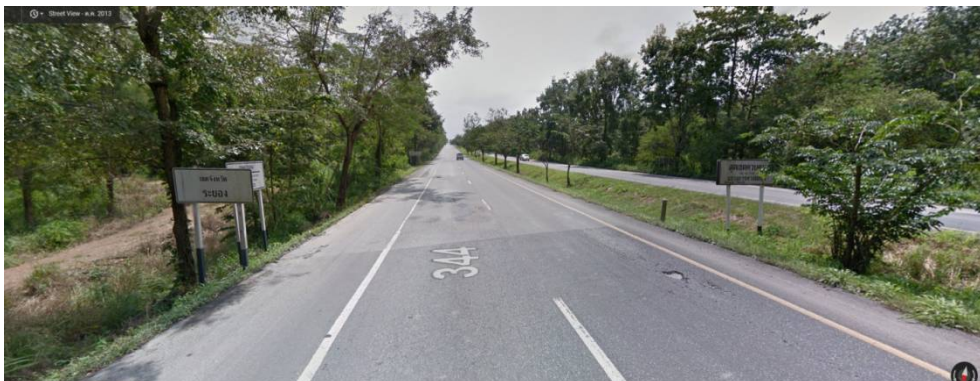
ภาพที่ 6.4 รูปก่อนการบูรณะทางหลวงหมายเลข 344 อ.บ้านบึง – อ.แกลง (ภาพจาก Google Street View)
