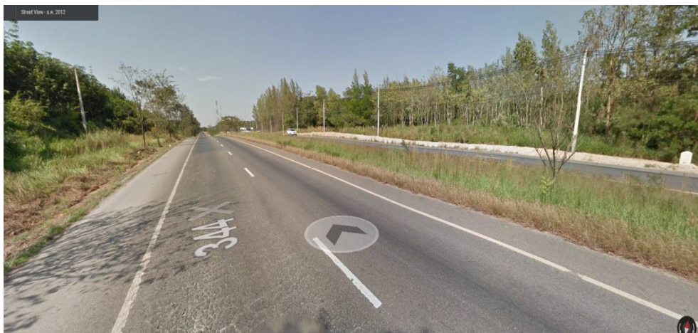
ภาพที่ 6.6 รูปก่อนการบูรณะทางหลวงหมายเลข 344 อ.บ้านบึง – อ.แกลง (ภาพจาก Google Street View)
