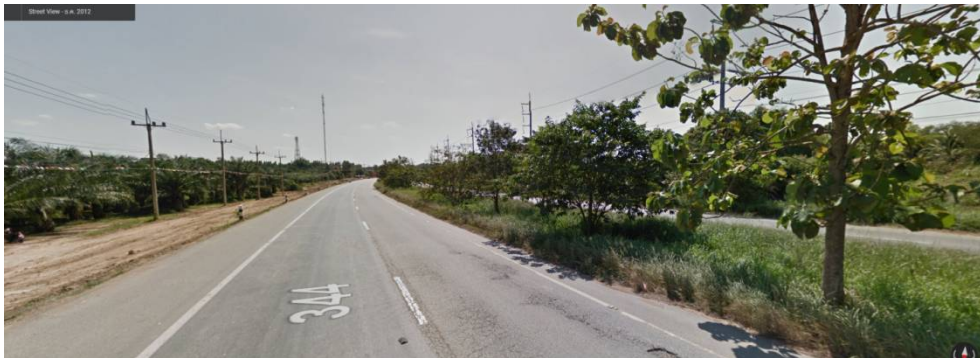
ภาพที่ 6.2 รูปก่อนการบูรณะทางหลวงหมายเลข 344 อ.บ้านบึง – อ.แกลง (ภาพจาก Google Street View)
